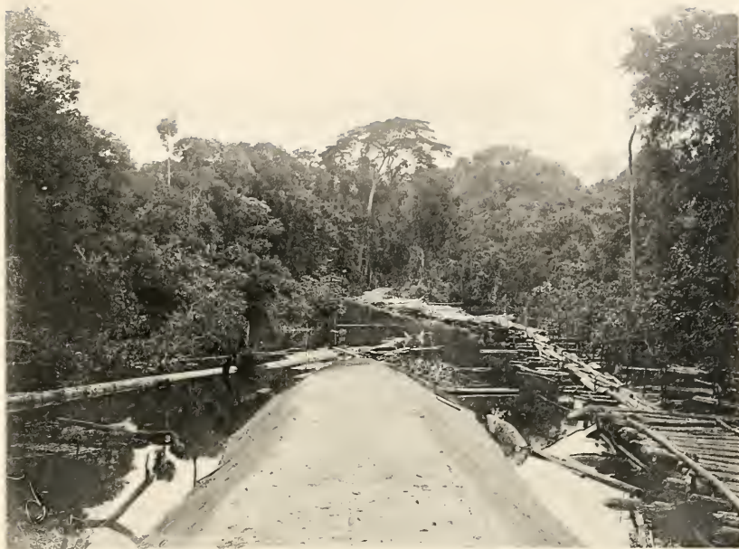
Notbrücke über den Limbi-Bach östlich Sangmelina bei Hochwasser.
